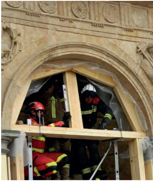
F9 : Protection de la surface de contact, Salamanca, 2017. © UGRECYL
