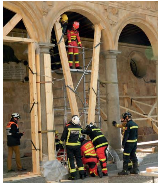
F10 : Travail de stabilisation de l'arche, Salamanca, 2017. © UGRECYL
