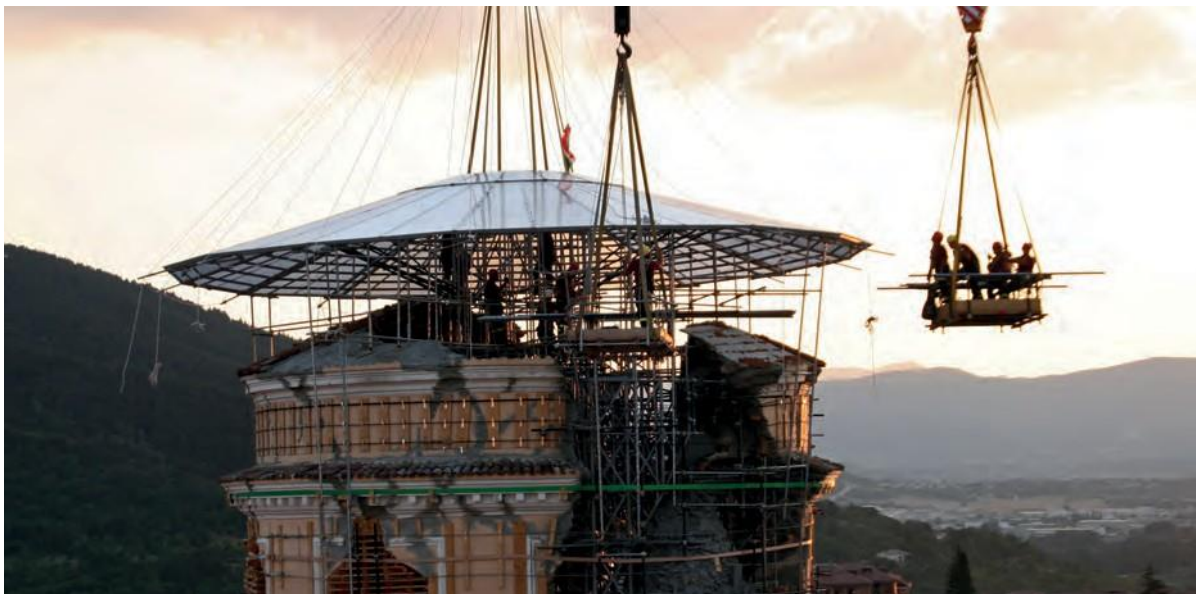
111 Couverture protectrice temporaire de l'église d'Anima Sante (L'Aquila) touchée par le tremblement de terre de 2009.
