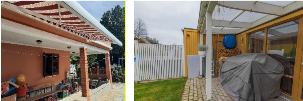
Beispiele für Veranden, in denen brennbare Elemente gelagert werden
