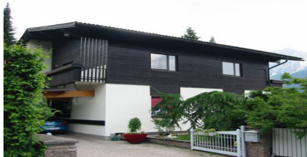
Haus mit dem brennbaren Teil der Fassade in einer Höhe von mehr als 1 m
