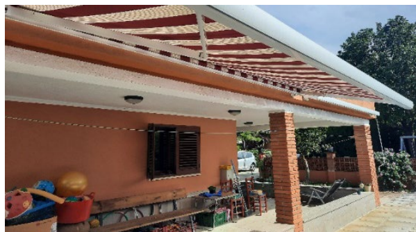
Die Wände, die den teilweise geschlossenen Raum mit dem Hauptgebäude verbinden, bestehen aus nicht brennbaren Materialien
