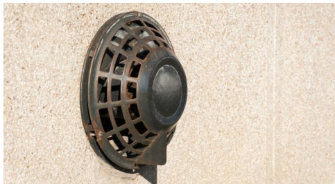
Beispiel für einen Lüftungsschutz in der Küche
