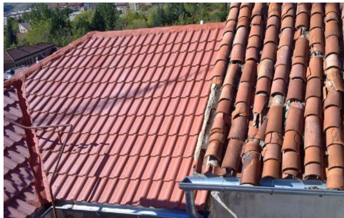
Beispiel für intakte und beschädigte Tonziegel
