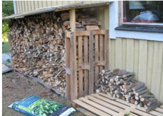
Beispiel für brennbare Elemente, die an einer brennbaren Fassade gelagert sind
