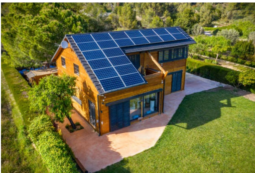
Beispiel für eine Fassade, die zu mehr als 50 % aus brennbaren Baustoffen besteht
