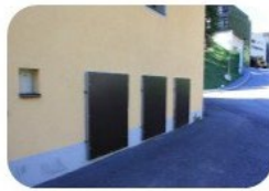
6. Meine Fenster sind ungeschützt, ohne Fensterläden oder außenliegende Jalousien.
